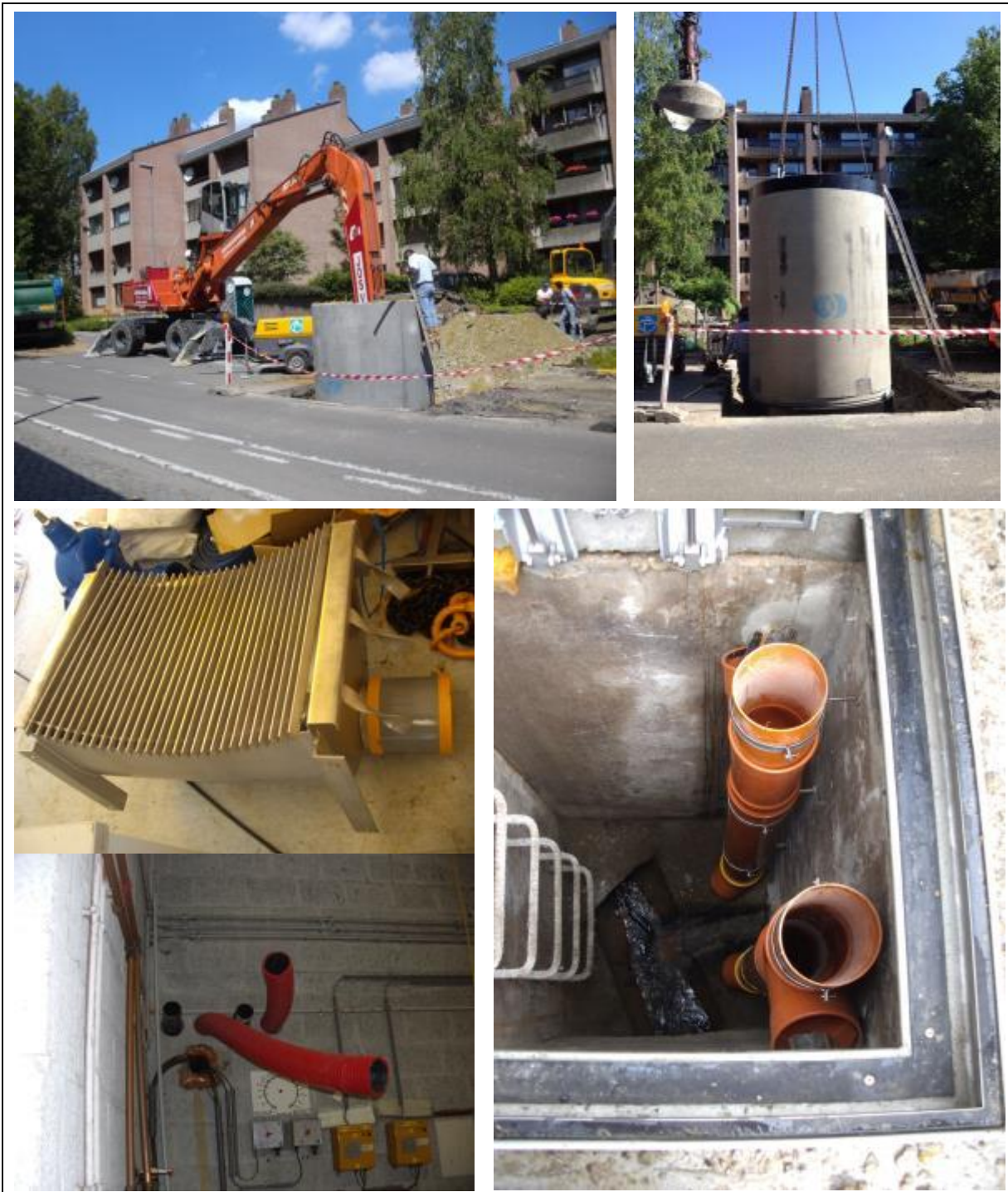
Figuur 21: Demonstratieproject VLARIO: boven: afzinken pompput; links midden: wateropvangbak met rooster; links onder: aansluiting persleiding in technisch lokaal; rechts onder: aansluiting retourleiding in bestaande put
