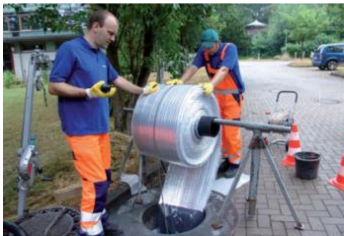
Figuur 9: Installatie van de Branderburger Heatliner
