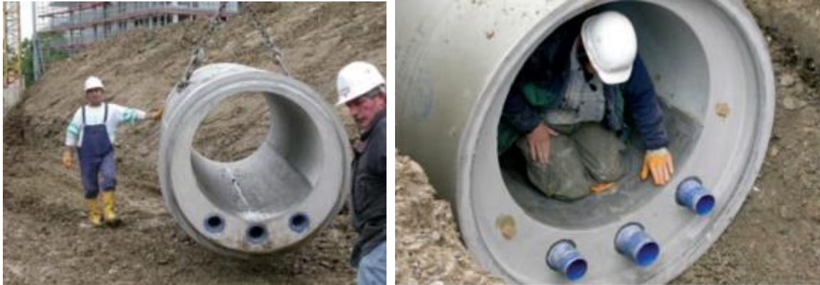
Figuur 14: In Zwitserland ontwikkelde rioolbuizen met ingebouwde warmtewisselaar
