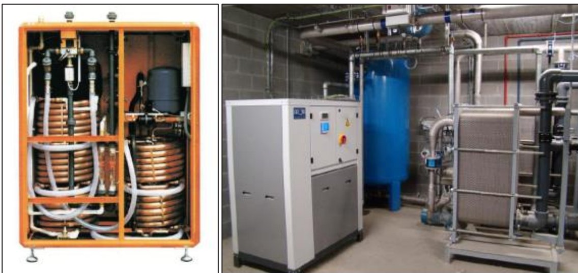
Figuur 3: Riothermie aan de bron: links: AquaCond® van Menerga – rechts: Bleu Hero® van Aaqua
